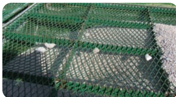
Slika 9. Mreža sprečava ulazak grudvi u svod rezervoara
